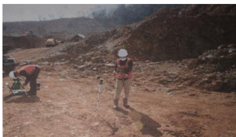
Gambar 9. Kondisi Hauling Road saat Pengukuran Kebisingan
